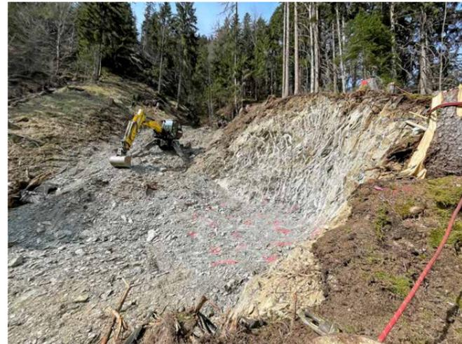
Ebenso gestartet ist mittlerweile auch der Bau der Wasserfassung unterhalb des Teufelgraben. Hier entsteht ein sogenannter Coanda-Rechen, der das Wasser aus dem Öxlbach abzieht und in einen Sandfang weiterleitet. An dieses Becken wird dann im nächsten Zuge die Druckrohrleitung angeschlossen. Wenn der Baufortschritt weiterhin so gut verläuft und die ausführenden Firmen termingerecht ihre Abschnitte fertig stellen, können wir aller Voraussicht nach vor Weihnachten mit einem Probetrieb starten.
